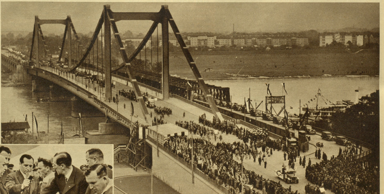
Die neue Reichsbrücke während des großen Festzuges, den das VF-Werk „Neues Leben“ veranstaltete. — Die Pylonentürme sind 33 1/2 m hoch, für die Herstellung der Fahrbahn und der Gehbahnen waren allein 10.600 Quadratmeter Asphaltbelag erforderlich. Links unten: Bundespräsident Miklas deutet durch Durchtrennung einer Kette die Eröffnung der Reichsbrücke symbolisch an.
